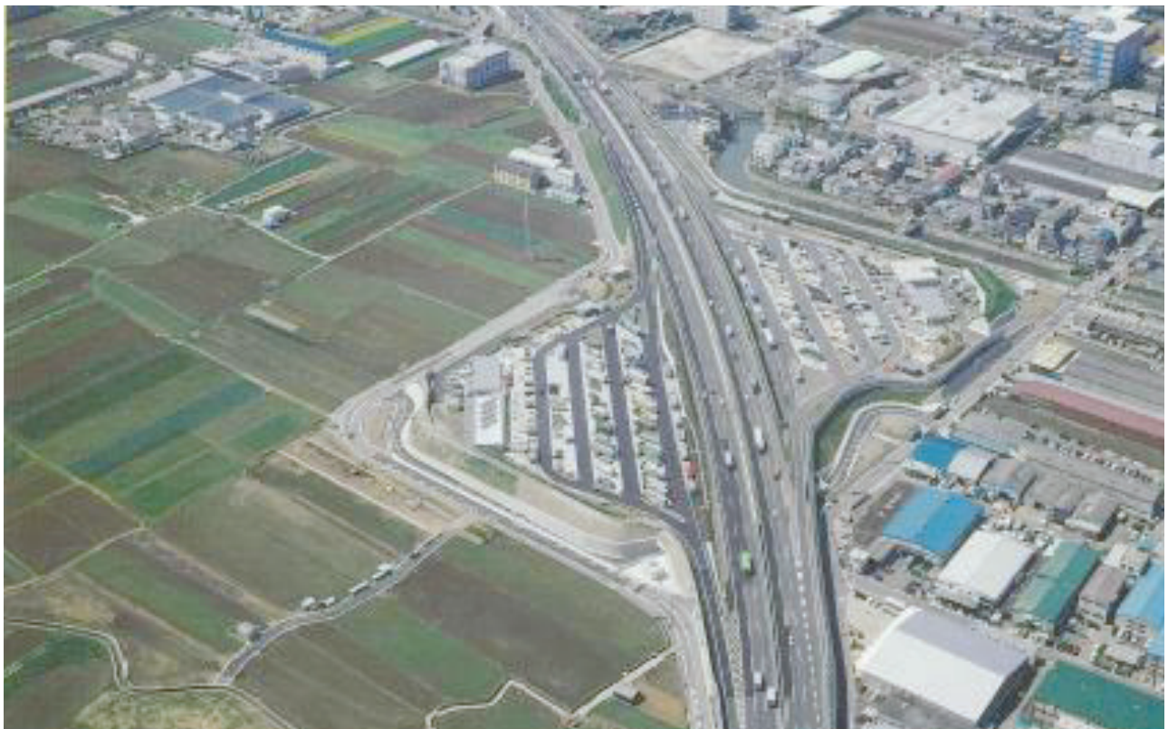
桂川パーキングエリア（提供：西日本高速道路株式会社）
