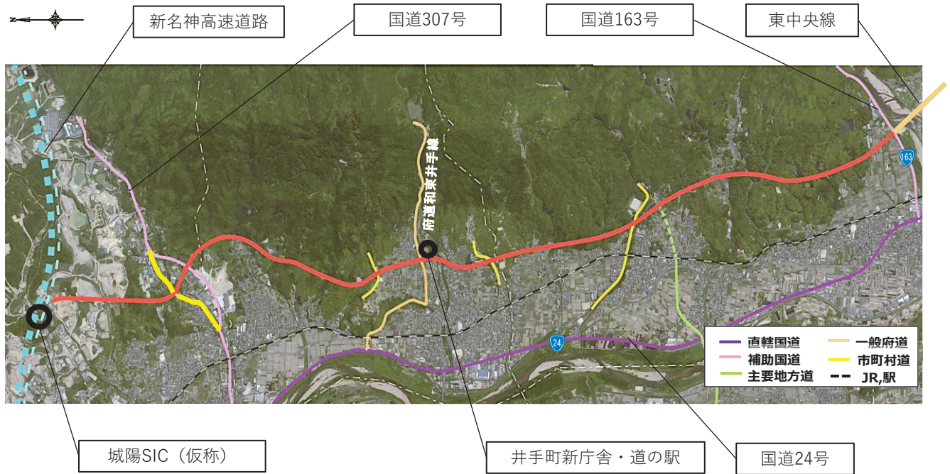
国道 24 号城陽井手木津川バイパスルート全景 (提供：国土交通省)
