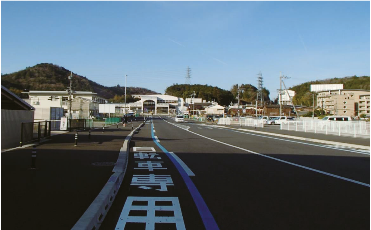
歩道、自転車専用帯設置、無電柱化実施状況（提供：京都府）
