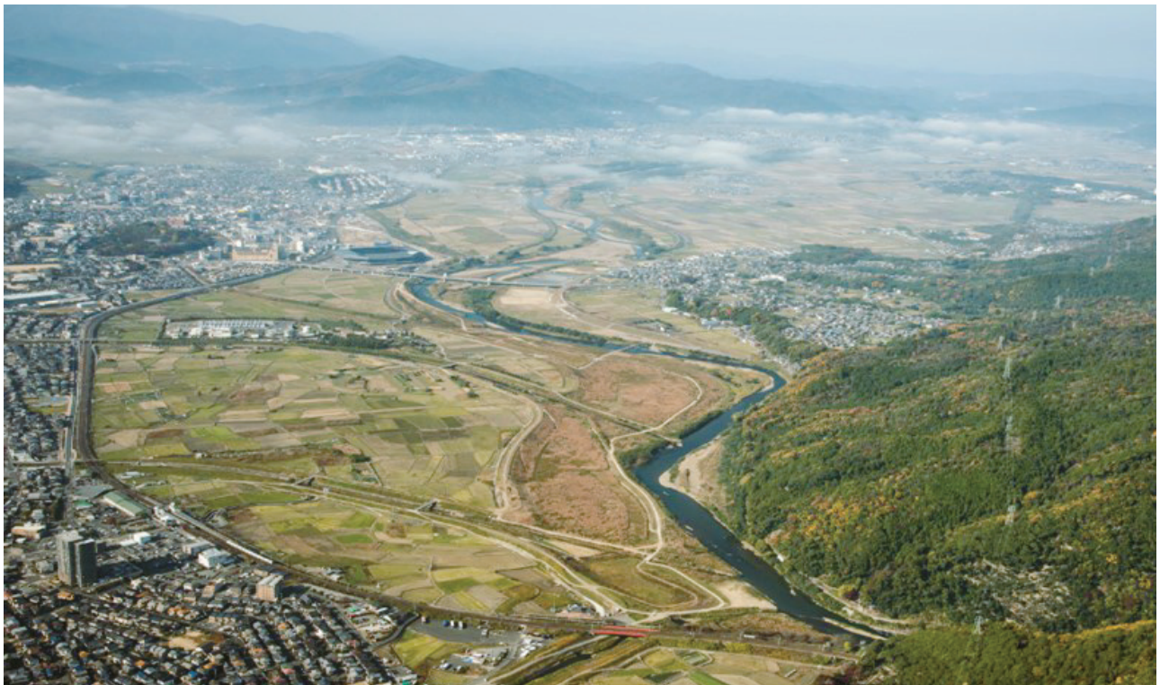
保津工区全景（提供：京都府）
