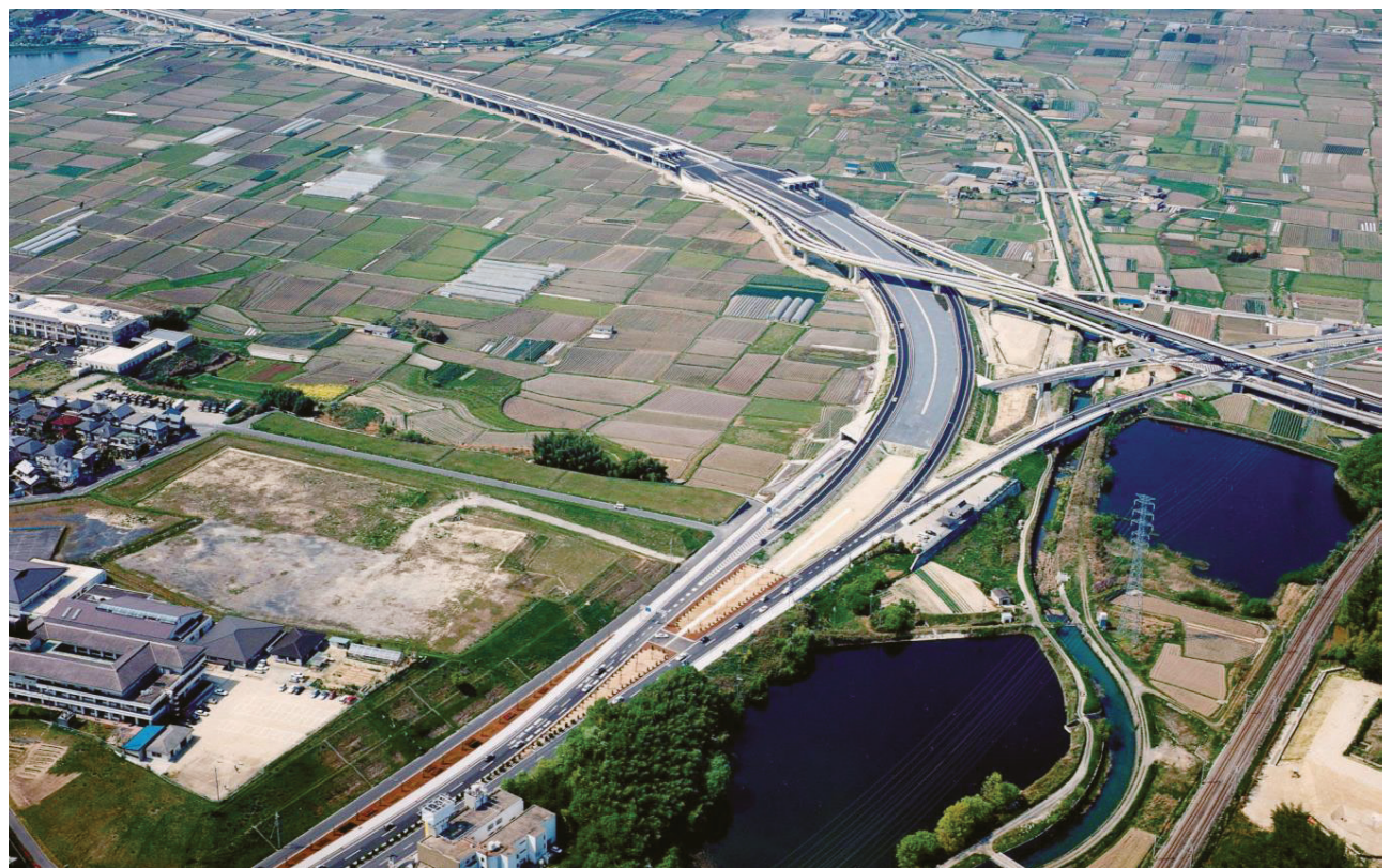
木津インターチェンジ (提供：国土交通省)
