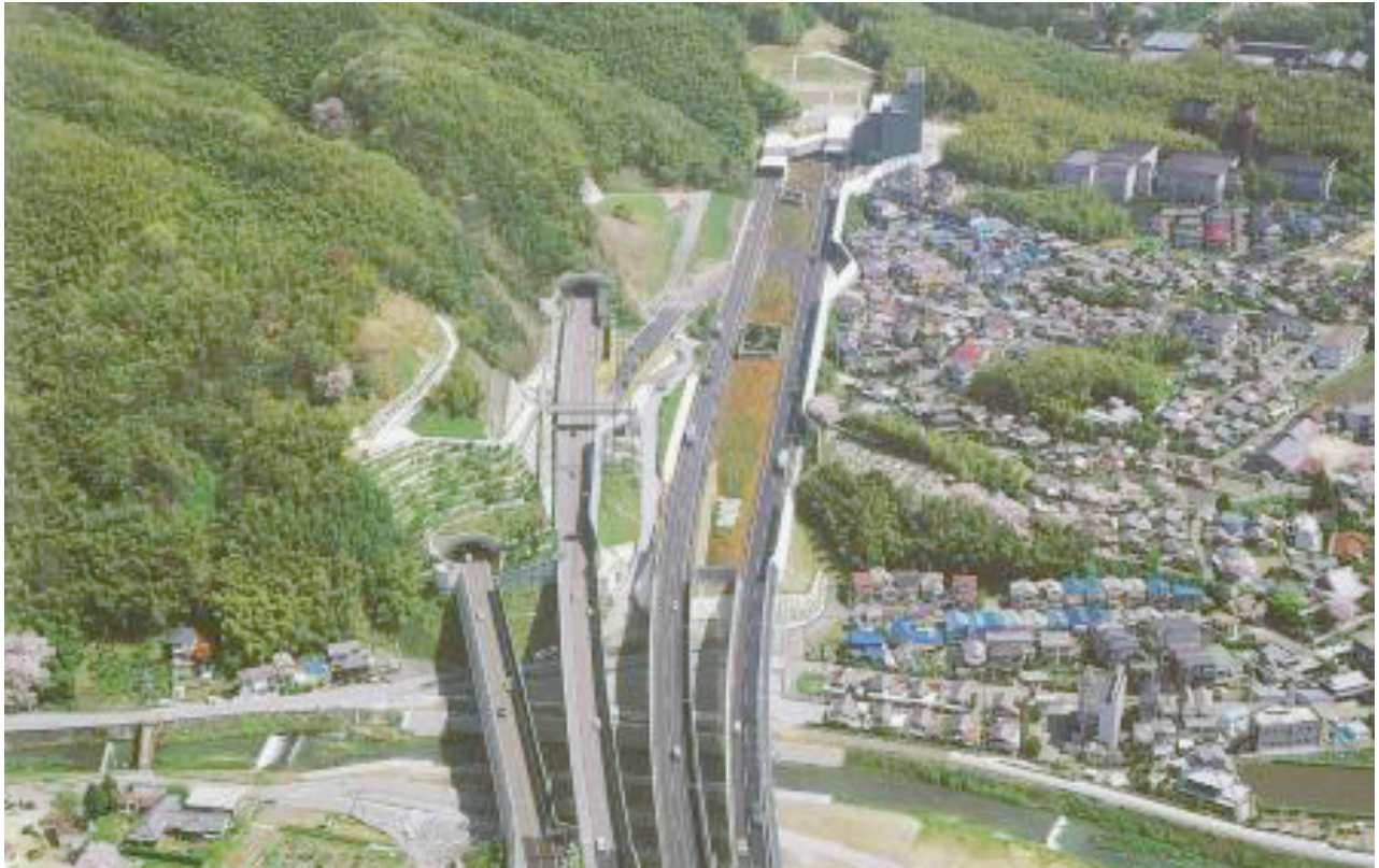
天王山トンネル西坑口（提供：西日本高速道路株式会社）
