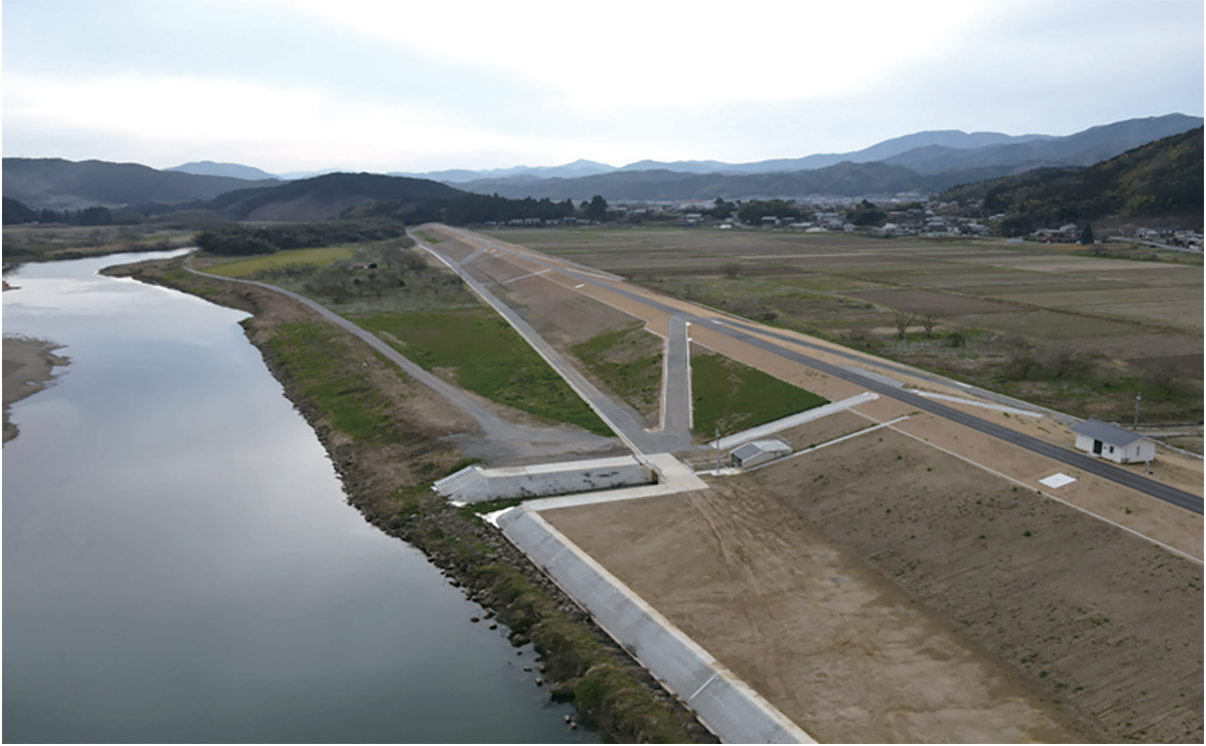
輪中堤整備完了箇所（福知山市大江町北有路）（提供：国土交通省）
