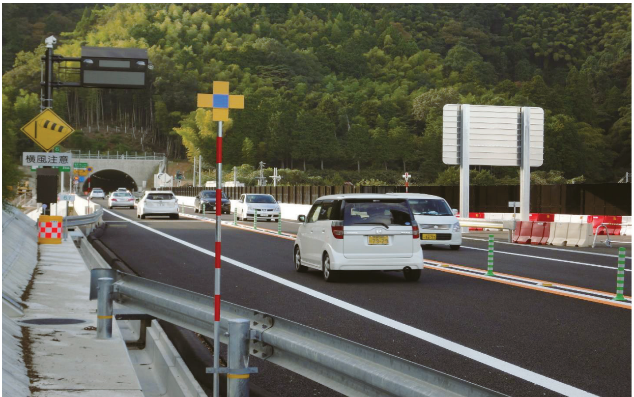
京丹後大宮インターチェンジ付近（提供：京都府道路公社）
