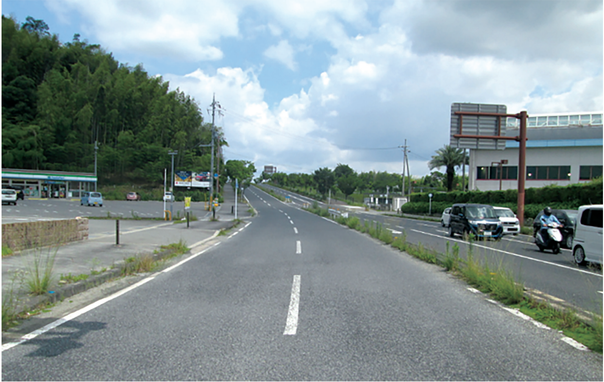
薪～田辺工区（京田辺市田辺）
