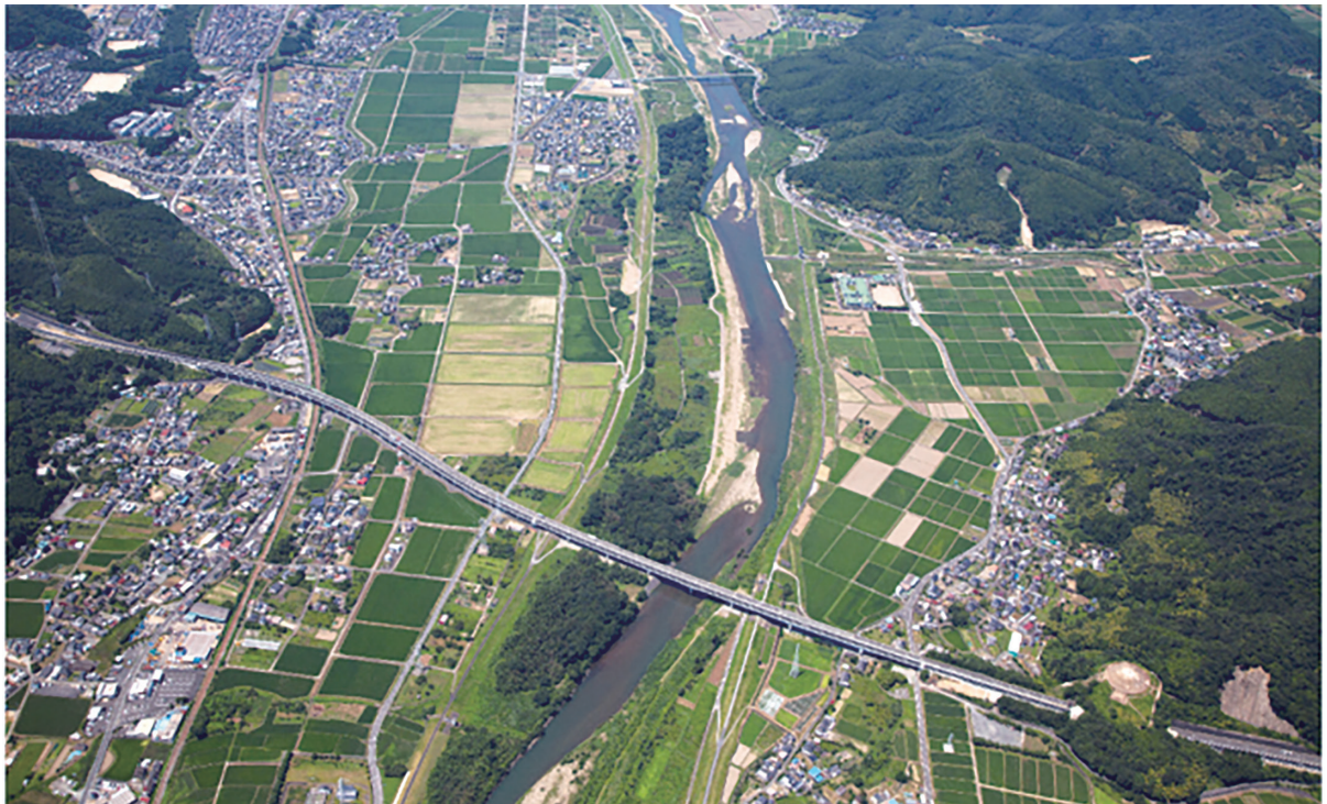
連続堤整備完了箇所（綾部市私市町）（提供：国土交通省）
