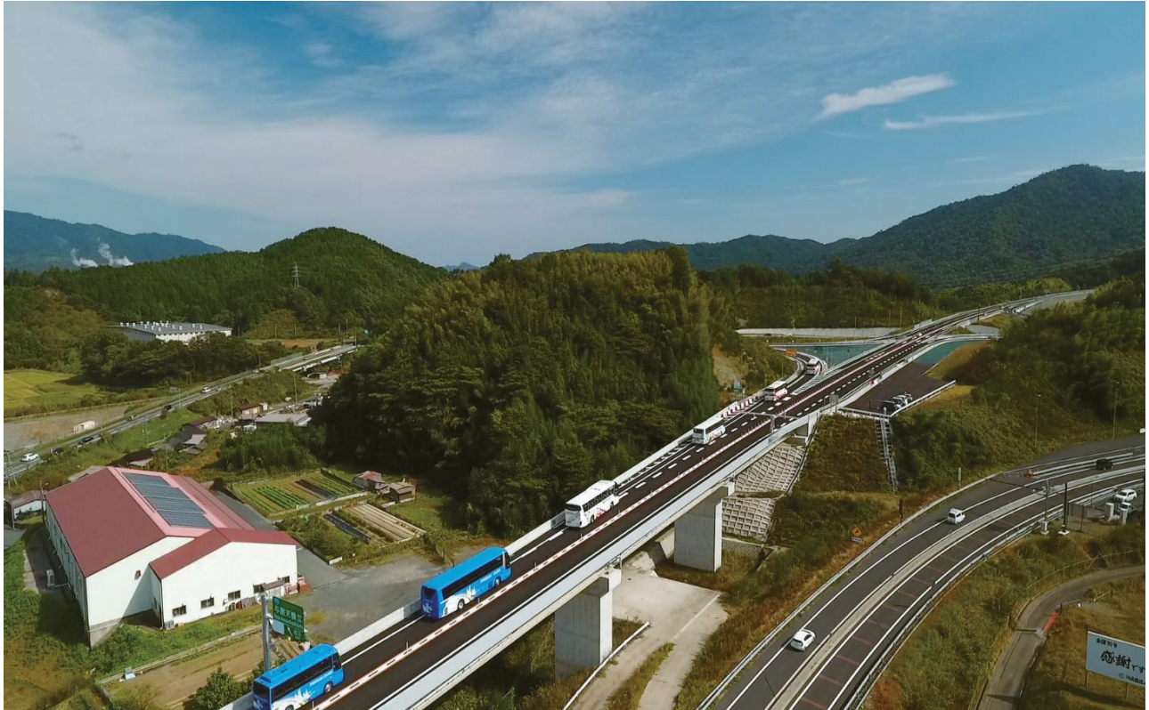
与謝天橋立インターチェンジ（提供：京都府道路公社）
