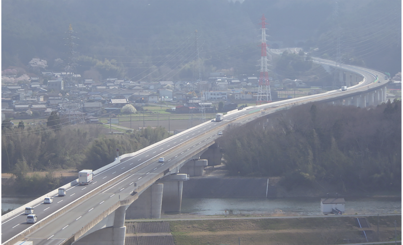
由良川橋（綾部市）（提供：西日本高速道路株式会社）
